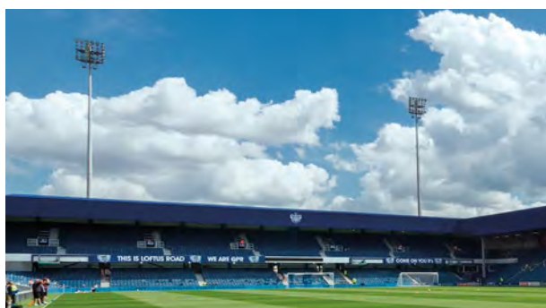
высокомачтовые опоры для освещения:
